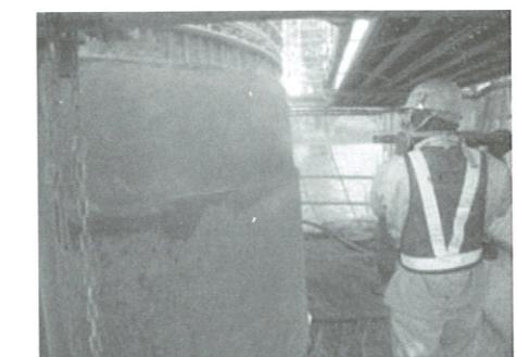
図-25 吹付け作業状況
