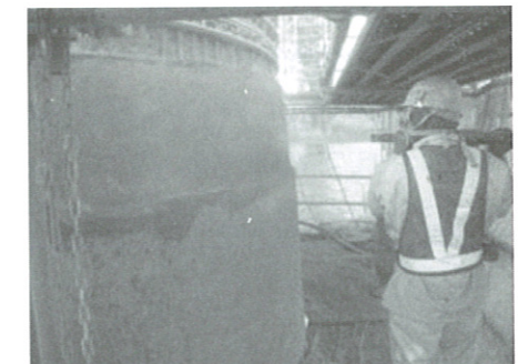
図-25 吹付け作業状況
