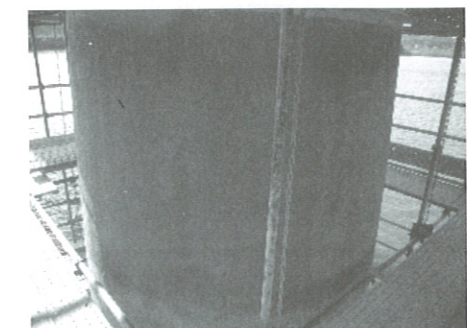
図-26 断面修復完了状況
