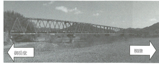
図-3 橋りょう全景写真
