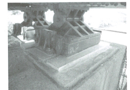
図-16 台座モルタル打替え完了
