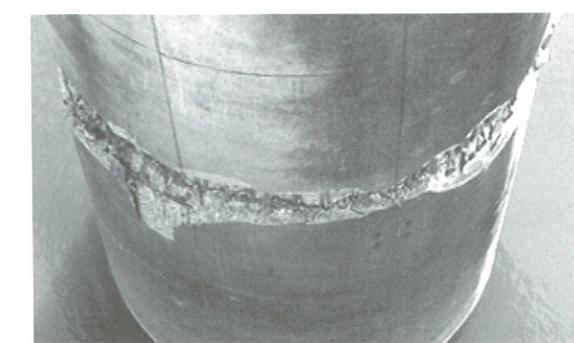
図-16 台座モルタル打替え完了
